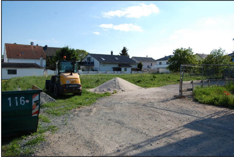
Blick auf die Wiesenfläche im Südwesten des Plangebiets. Foto: INFRAPRO, 15.05.2020.
