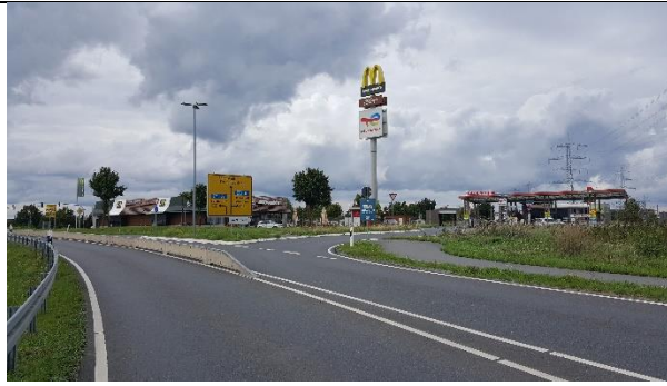
Blick nach Nordwest, von Westumgehung aus in Richtung Zufahrt Tankstelle
