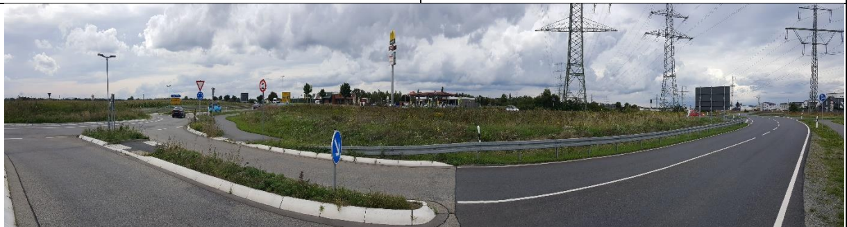
Panoramaaufnahme von Retfordstraße aus nach Nordwesten in Richtung Tankstelle
