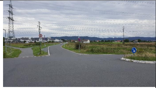
Blick nach Osten, von Zufahrt Tankstelle aus in Richtung Eschollbrücker Straße
