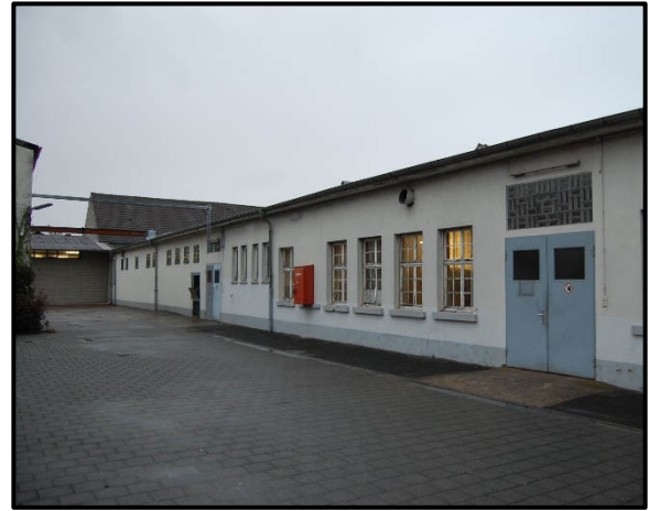
Betriebshalle auf dem Firmengelände sowie davorliegender Hofbereich
