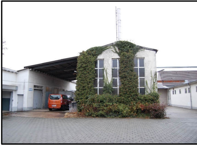
Gaskesselhaus/Feuerungsanlage inmitten des Plangrundstückes
