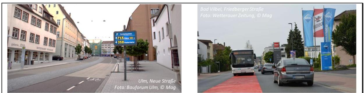
Abbildung 16: Ausführungsbeispiele von Mehrzweck-Mittelstreifen
